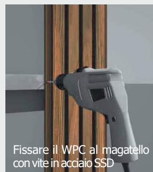
Preforare il WPC ed il magatello ad una profondità idonea
